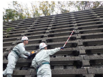
急傾斜地崩壊防止施設点検
