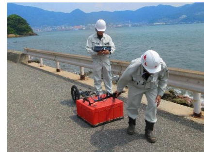
地中探査レーダーによる沿岸部空洞調査
