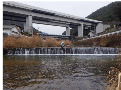
渓流保全工定期点検
