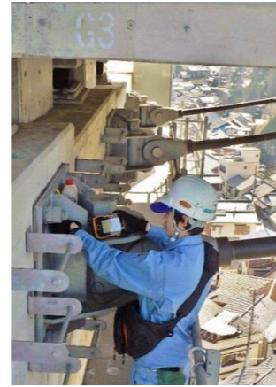
超音波探傷検査による落橋防止装置点検
