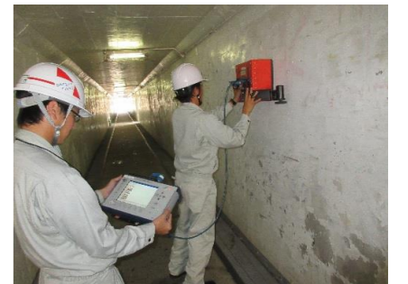
地中探査レーダーによる人道トンネル空洞調査
