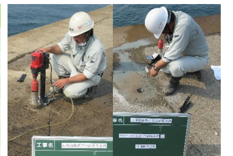
ファイバースコープによる空洞調査
