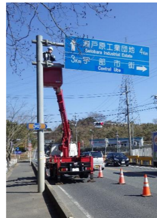
目視及び打音, 超音波厚さ計による道路付属物点検
