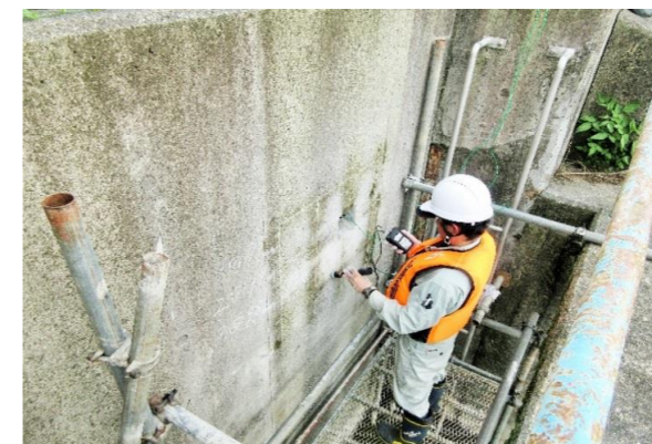
コンクリート構造物調査 (中性化・鉄筋腐食調査)
