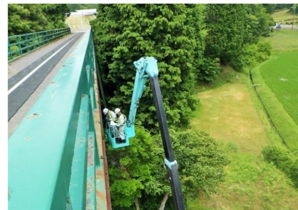
橋梁定期点検
