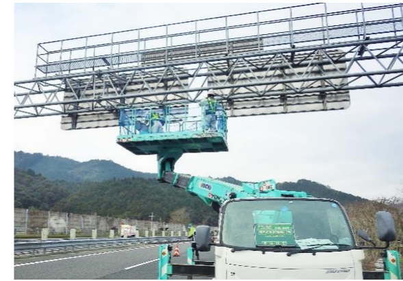
道路附属物定期点検
