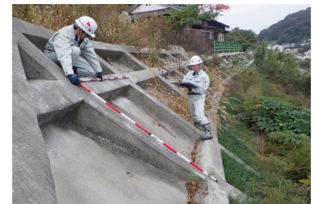
法面定期点検
