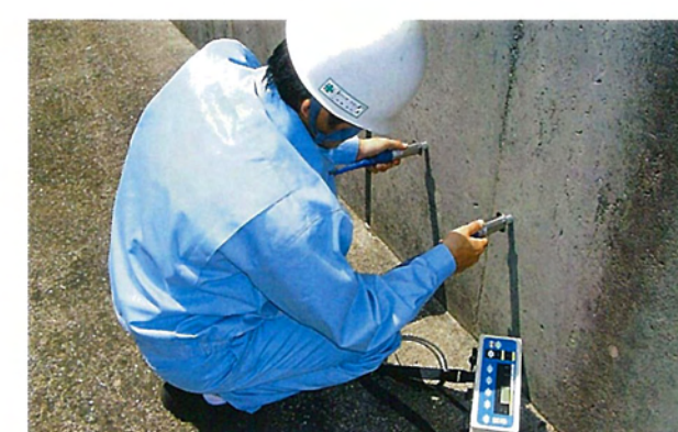
◎ひび割れ深さ・強度測定（超音波デジタル表示）
