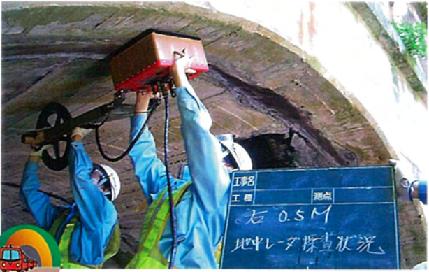
◎トンネル背面空洞調査
