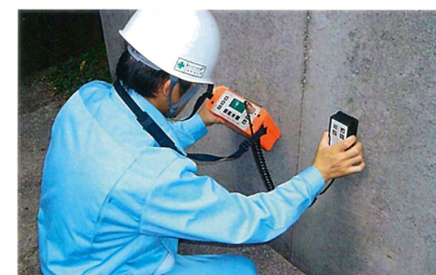
◎配筋・かぶり調査（電磁誘導法）
