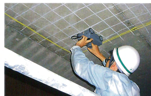
◎鉄筋・かぶり探査（電磁波レーダ法）
