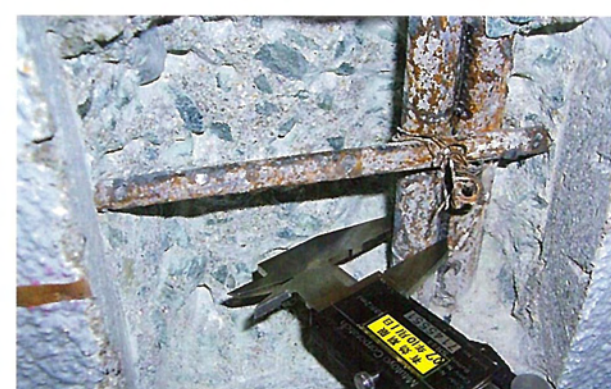
◎鉄筋腐食度調査
