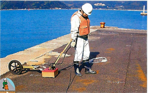
◎護岸変状調査
