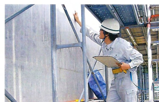
◎外観目視調査
