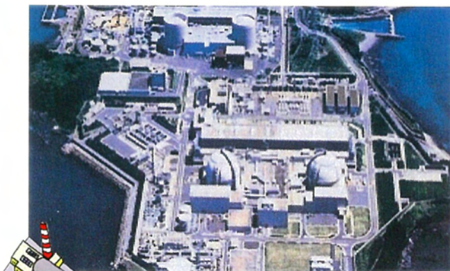
◎原子力発電所
