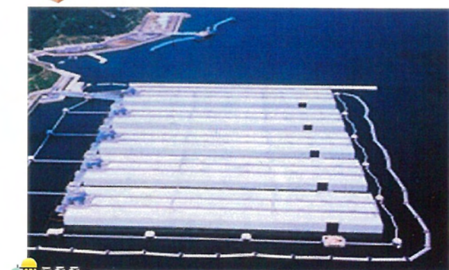
◎石油備蓄基地
